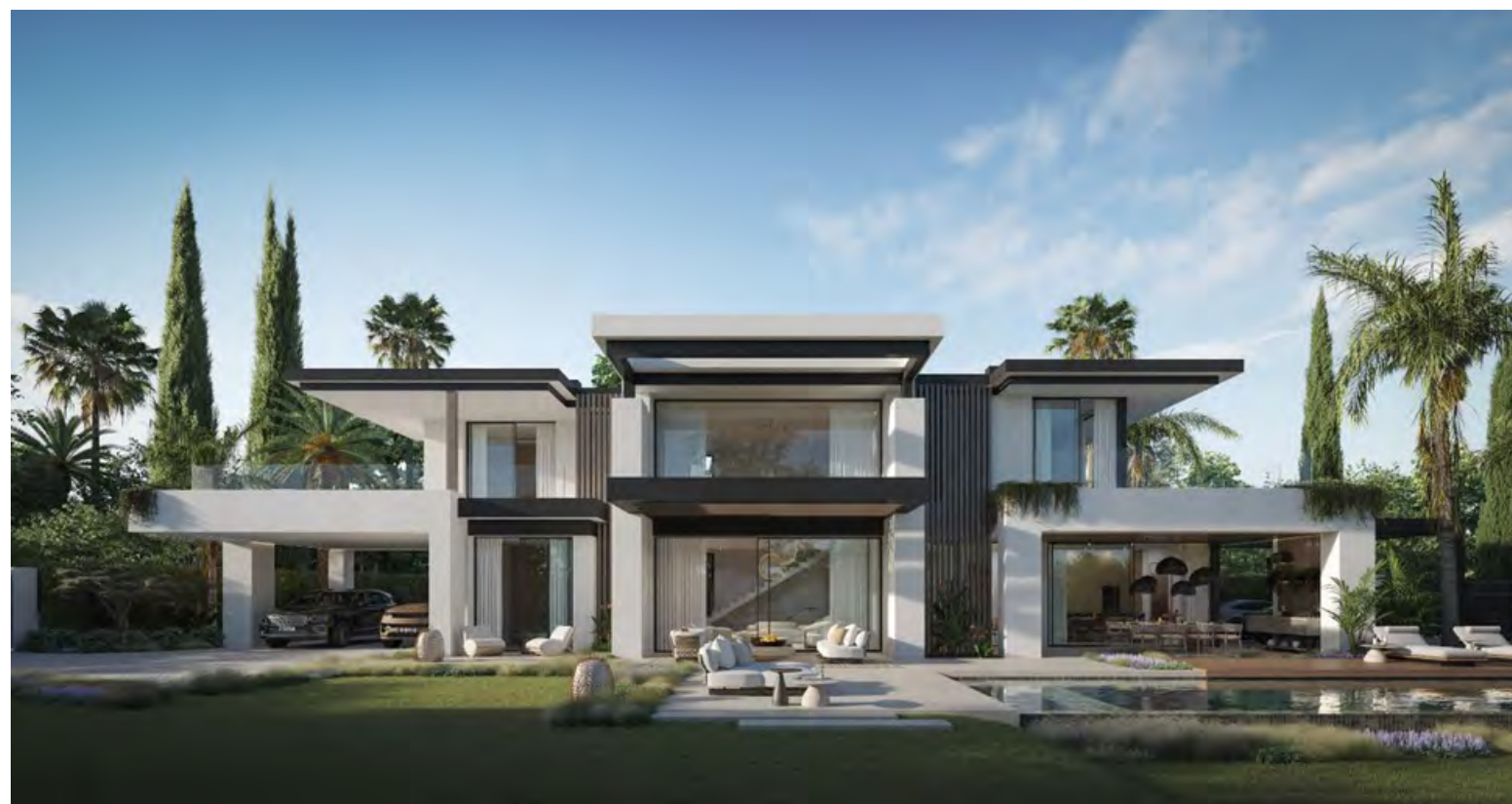
Fachada zona jardín de la vivienda.
