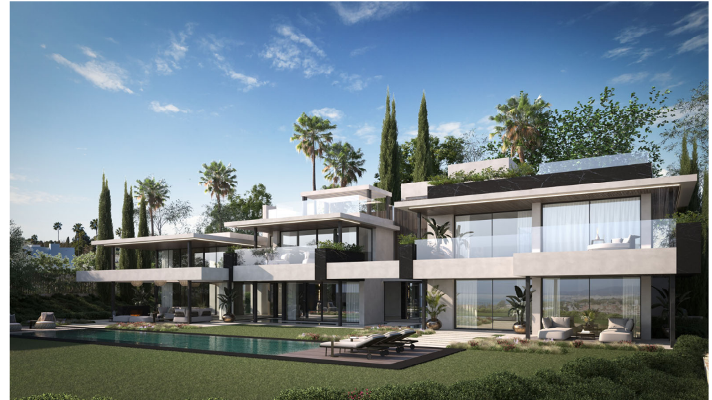
Vista de las carpinterías de aluminio y de las barandillas de vidrio.
